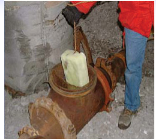
Floc Log colocado en una tuvo.
