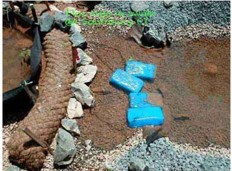
Floc Log colocado en una zanja, usando algunas técnicas de aplicación
