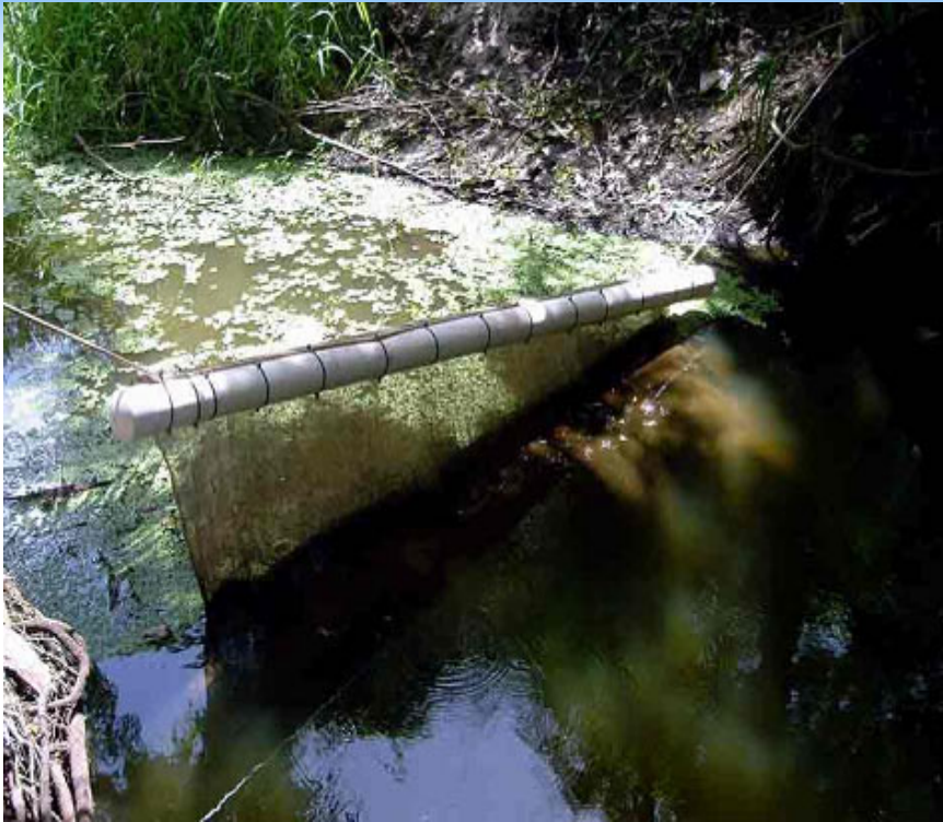
Se coloca la cortina de partículas estratégicamente para detener el sedimento que no se logra capturar.
