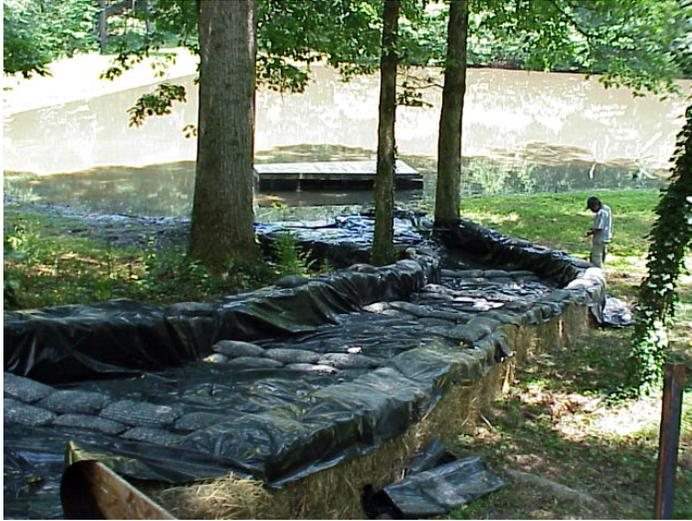
El agua se dirigió a la cámara que se construyó donde estaba la base con divisiones y los Floc Logs 706B, en donde el polímero empezaría a reaccionar con las partículas finas de sedimento, uniéndolas. Entonces el agua se envió por el canal a la serie de paneles que estaban cubiertos con una capa de yute antes de ser descargados atrás en el tanque.
