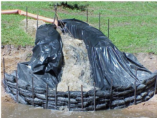
El sistema de Aclaración consistió en una cámara de mezcla y una base con divisiones, usando una lancha a remolque con un mezclador de vacío, el sedimento se revolvió, y este se aspiró constantemente a la cámara diseñada para sostener 250 yd<sup>3</sup> de sedimento arrastrado encontrado ahí.
