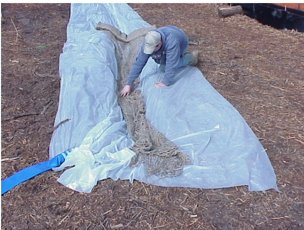
3) Lay jute matting
