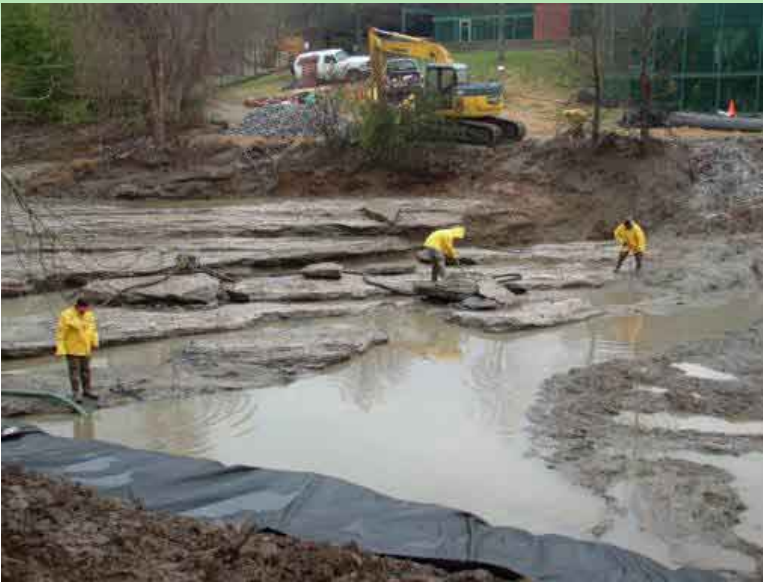
Bombeando el agua lejos para ver el sedimentos antes de extraerlo.
