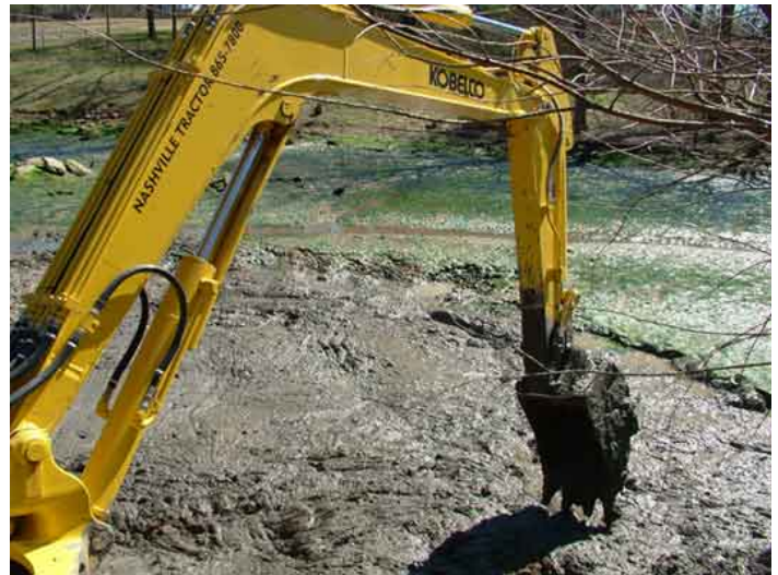
APS Silt Stop solidificado el sedimento para hacer el retiro fácil
