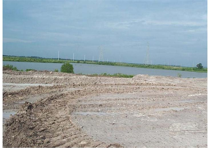
Las aguas de lluvia habían llevado el exceso de sedimento a los estanques de retención, causando problemas de turbiedad. El exceso de agua necesitaba sacarse rápidamente para que no se desbordara el estanque. De hecho las operaciones de desecación se removerían encima del sedimento, causando una turbiedad muy grande en los estanques y en el agua que se descargaría.
