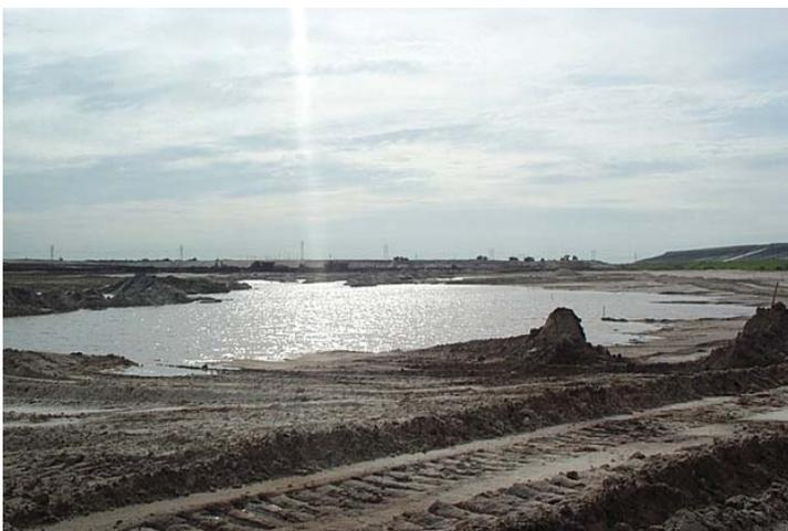
Moretrench contacto con R. H. Moore and Associates, Inc. de Tampa para evaluar la turbiedad y encontrar una solución factible. Después de ir al lugar y revisar se determino que la solución al problema era el tratamiento de zanjas y el sistemas de obstáculos con APS Flocc Logs las cuales no interferirían y serian mas rentables, permitiendo una arreglo rápido y una fácil recolocación si era necesario.
