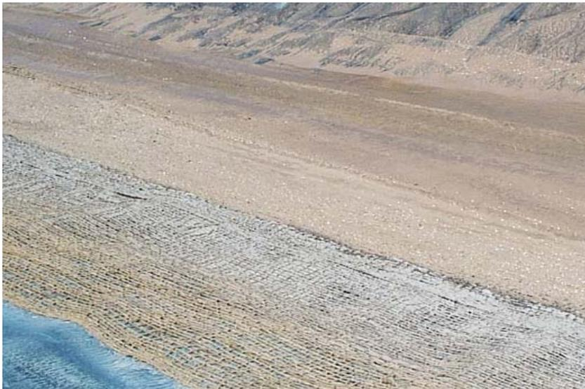
El Yute fue colocado al final de la zanja y se aplicó APS 705 Silt Stop powder. El yute proporciona una superficie floculada para adherir y el 705 powder ayuda a la retención de las partículas finas de suspensión.
