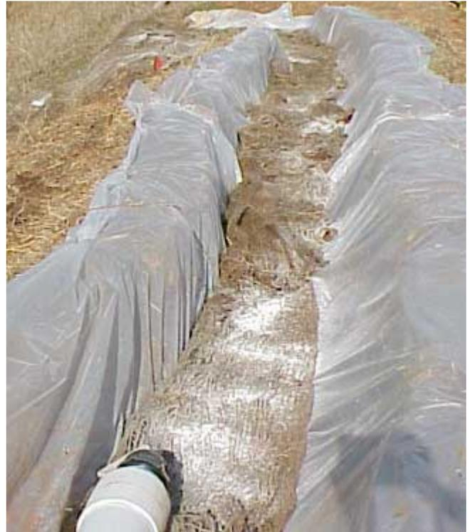
**La zanja fue hecha con 2 filas de paja cubiertas de plástico y se colocan dos capas de yute que se rocían con el apropiado Silt Stop® powder.**
