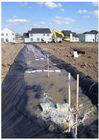
Para determinar los polímeros mas apropiados, se realizo una prueba del lugar. Esta prueba ayuda a determinar el tiempo de reacción requerido para que el sedimento dejara el agua. Entonces se determina el caudal previsto, y después se diseña el tamaño de canal de tratamiento
